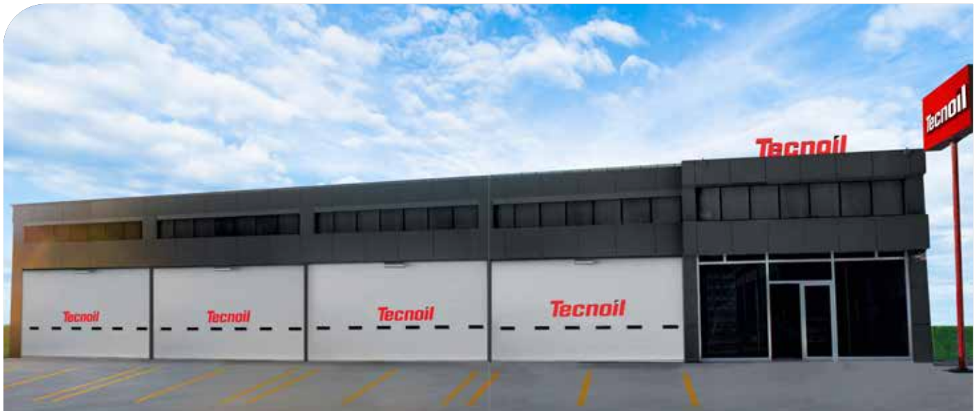
Madeni Yağ Üretim Tesisi
